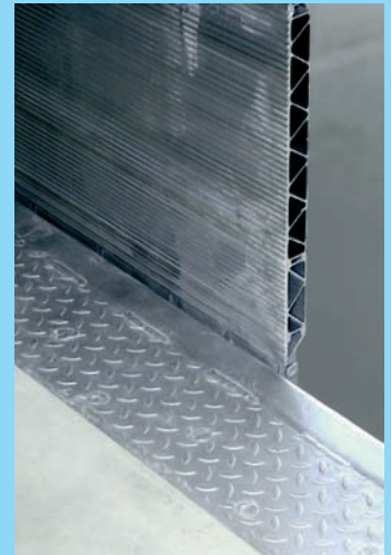
Bündig mit der Rampenkante abschliessend – obere Verschweissung.
