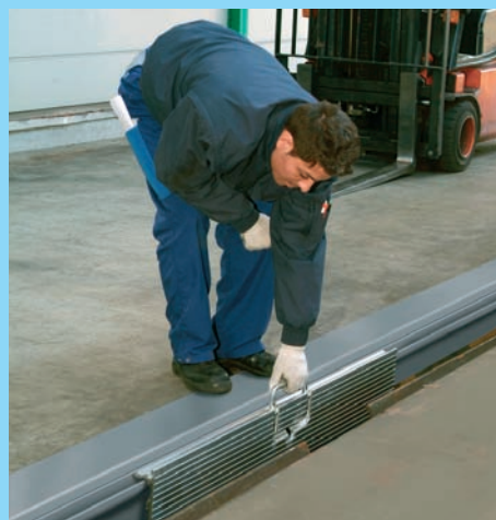
BB-Brücke aus der Führungsschiene herausheben.
